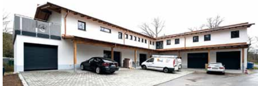
Die Gemeinschafts- und Mietbäder befinden sich in einem eigens dafür gebauten Neubau.
